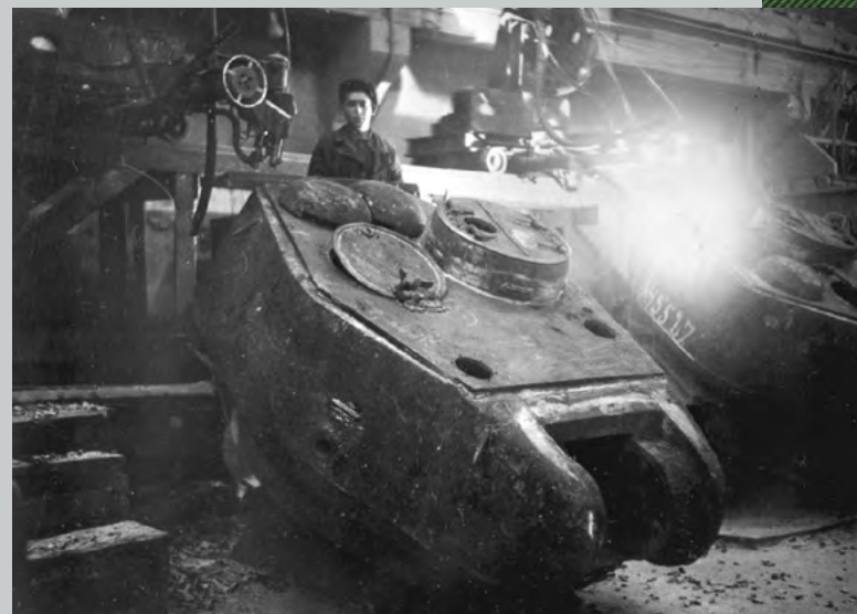
Автоматическая сварочная установка для приварки крыши к корпусу башни. 1944-1945 гг. Фотография из фондов музея УВЗ
